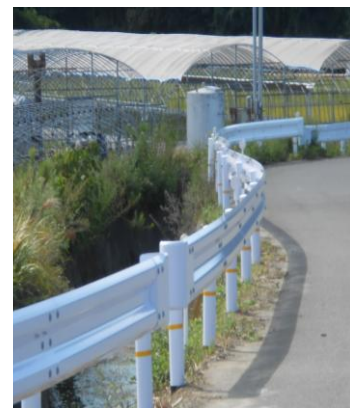
ガードレールが設置(須多田)
