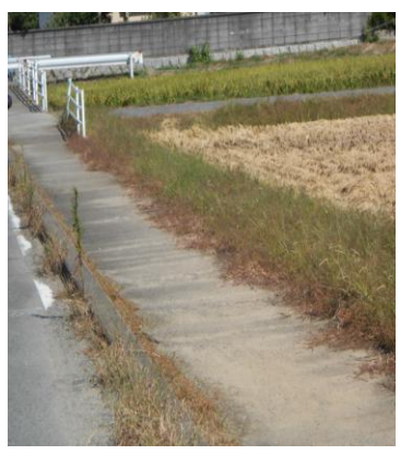
腐食したガードポールを撤去(勝浦区)
