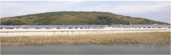
津屋崎(内海の奥)に建設中の太陽光発電設備
